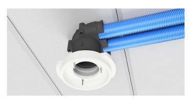
1 . Marquez l'emplacement d'installation prévu du diffuseur sur les plaques de plâtre et découpez un trou d'un diamètre d'environ 240 mm. Pour ce faire, vous pouvez retourner le diffuseur et le délimiter au crayon. Le diffuseur lui-même a un diamètre de 235 mm, tandis que le trou doit être légèrement plus grand pour permettre au diffuseur d'être inséré à travers le trou lors d'une étape ultérieure de l'installation.
