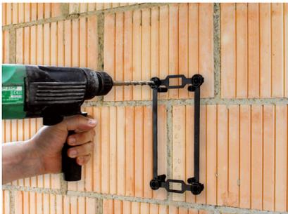
Mit Hilfe der Unterlage zweites Bohrloch bohren.
