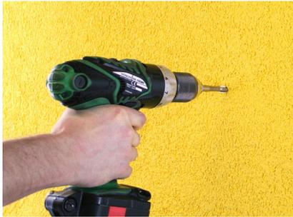
Gewinde durch die Compact- und Aluplatte schneiden.
