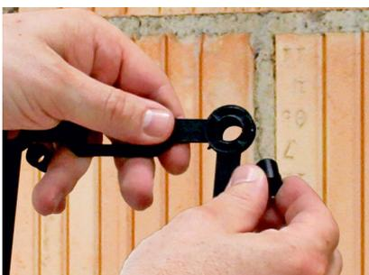
Bei der Unterlage Positionierstifte herausnehmen, die vier Büchsen abbrechen und diese in die Löcher in der Unterlage einpressen.
