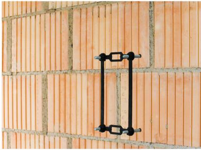
Gewindestangen setzen und mit Hilfe der Unterlage genau ausrichten. Die Unterlage darf nicht bis nach hinten geschoben werden. Injektions-Mörtel aushärten lassen. Nach dem Aushärten Unterlage abziehen und überschüssiges Material entfernen. Bei Mauerwerk mit Lochsteinen müssen zwingend Injektions-Ankerhülsen verwendet werden.
