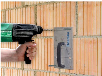
Anstelle der Unterlage können die weiteren Bohrlöcher mit Hilfe der Bohrlehre UMP® / TRA-WIK® / TWL® gebohrt werden.
