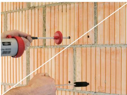
Bohrlöcher müssen gründlich vom Bohrstaub gereinigt werden.
