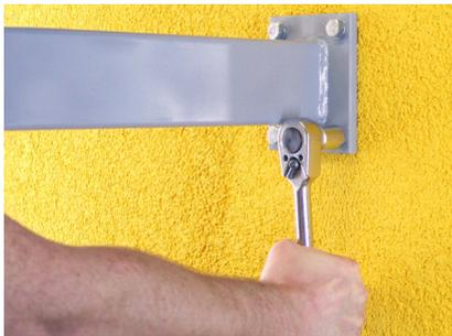
Avvitare componenti nella piastra di montaggio universale UMP®-ALU-TR.
