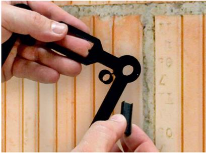
Bei der Unterlage einen Positionierstift herausbrechen und in das dementsprechende Loch stecken.
