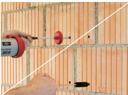
Eliminare accuratamente la polvere accumulata nei fori.
