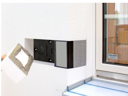
Passstück aus Dämmplattenmaterial für vorhandene Aussparung zuschneiden, Klebemörtel aufziehen und dämmplattenbündig anpressen.
