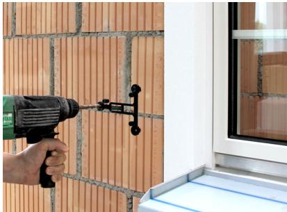
Mit Hilfe der Unterlage zweites Bohrloch bohren.
