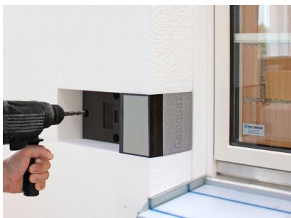
Nach dem Aushärten des Klebemörtels Schraubdübel versetzen. Mauerwerke mit Lochsteinen ohne Schlag bohren.
