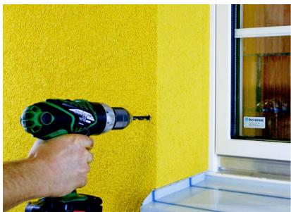
Bohrloch durch die Compact- und Aluplatte bohren.
