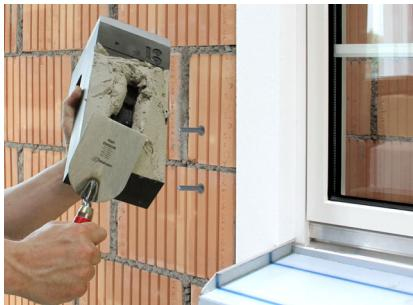
Unterlage auf Tragwinkel TWL®-ALU-RF setzen.
