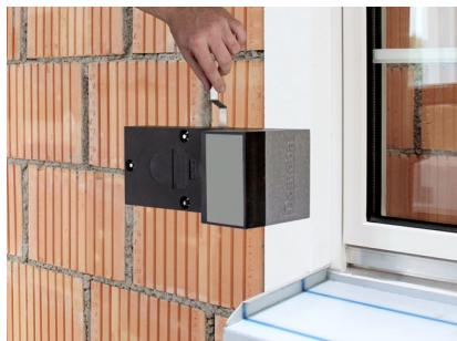
Regolare la posizione dell'staffa di montaggio pannelli TWL®-ALU-RF attraverso i piedini di regolazione in modo che sia a filo con la facciata. Campo di regolazione 5–15 mm.
