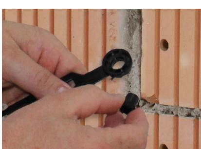
Bei der Unterlage Positionierstifte herausnehmen, die drei Büchsen abbrechen und diese in die Löcher in der Unterlage einpressen.
