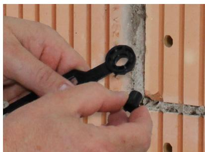
Estrarre alla base le spine di posizionamento, rompere le tre boccole e infilare le spine nei fori della base.
