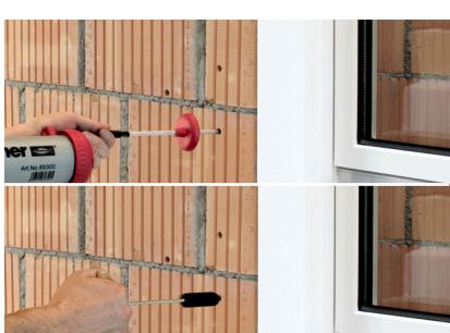
Bohrlöcher müssen gründlich vom Bohrstaub gereinigt werden.
