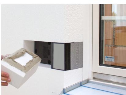
Ritagliare l'adattatore del materiale del pannello isolante per la nicchia esistente, preparare della malta adesiva premere a fondo a filo dei pannelli isolanti.
