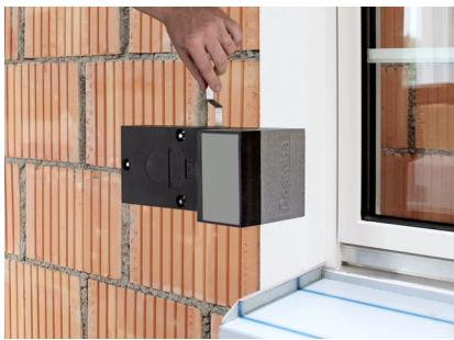
Mit den Stellfüßen Tragwinkel TWL®-ALU-RF auf Fassadenflucht ausrichten. Verstellbereich 5–15 mm.
