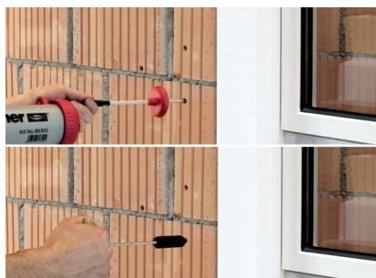
Eliminare accuratamente la polvere accumulatisi nei fori.
