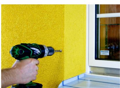
Gewinde durch die Compact- und Aluplatte schneiden.
