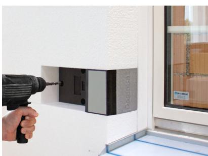
Dopo l'indurimento della malta adesiva applicare i perni di fissaggio. Trapanare i muri con mattoni forati senza utilizzare la funzione percussione.
