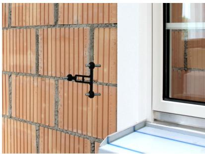
Gewindestangen setzen und mit Hilfe der Unterlage genau ausrichten. Die Unterlage darf nicht bis nach hinten geschoben werden. Injektions-Mörtel aushärten lassen. Nach dem Aushärteten Unterlage abziehen und überschüssiges Material entfernen. Bei Mauerwerk mit Lochsteinen müssen zwingend Injektions-Ankerhülsen verwendet werden.
