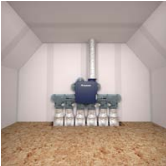
Plusieurs conduits aérauliques vers le bas
