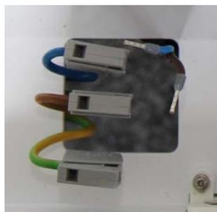
3. Poser les raccords de serrage de façon ordonnée et en réduisant l'encombrement pour assurer un montage sans problème du boîtier en plastique de recouvrement du raccordement électrique.
